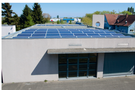
En matière de panneaux photovoltaïques, le village a construit un parc sur une friche industrielle, mais aussi équipé tous les bâtiments communaux.
